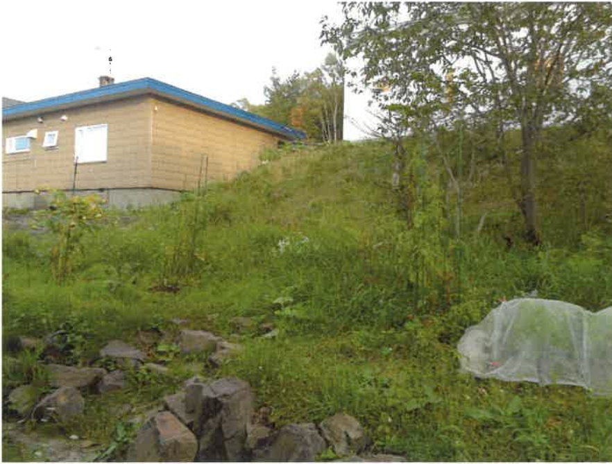
本件土地の略南東側の形状(法面の状況)
